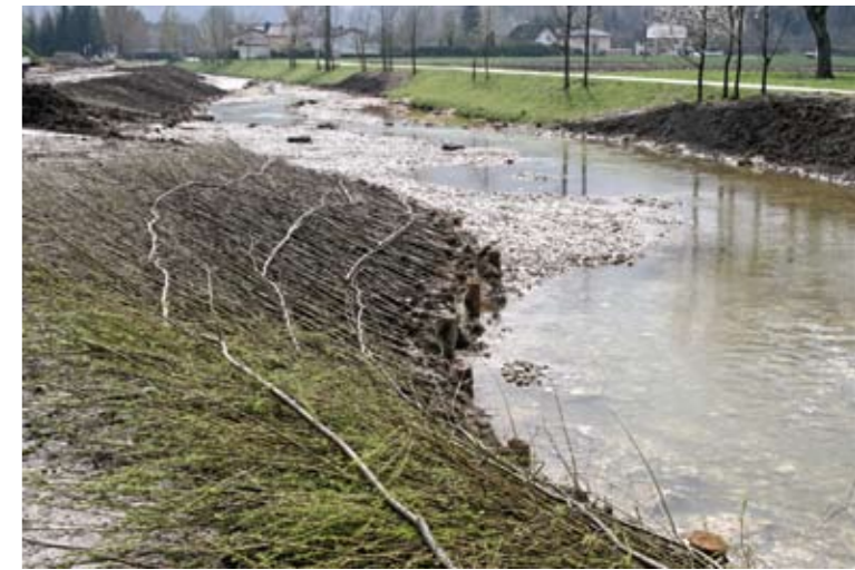
Die Böschungen werden mit Humus bedeckt und die Weidenspreitlagen aufgebracht.
