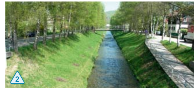
In strengem Trapezprofil fließt die Glan durch den Hochwasserentlastungskanal und mündet beim Messezentrum in die Salzach.
