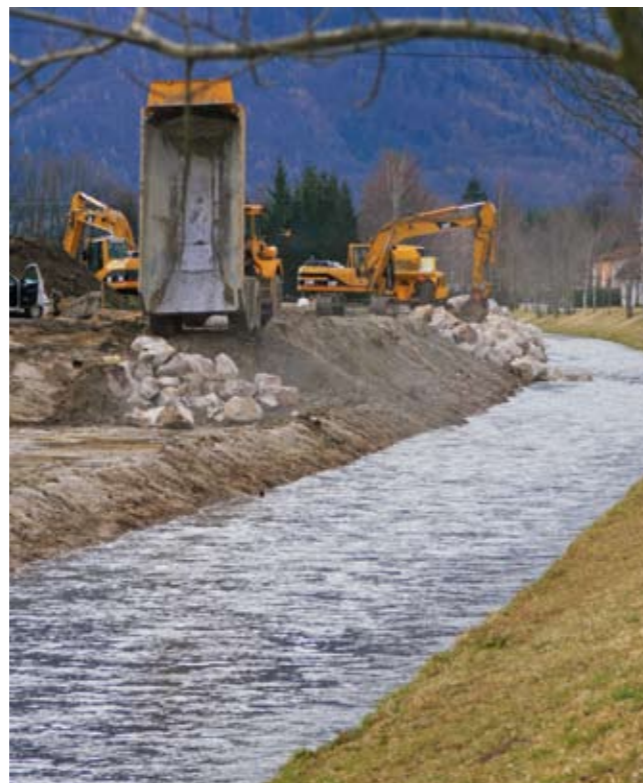
Um Seitenerosion zu verhindern, werden an gefährdeten Stellen Steinsicherungen eingebaut.
