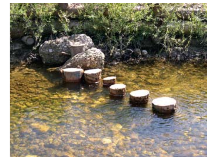
sowie Holzpilotierungen in Form von Krainerrwänden & Buhnen eingebaut.
