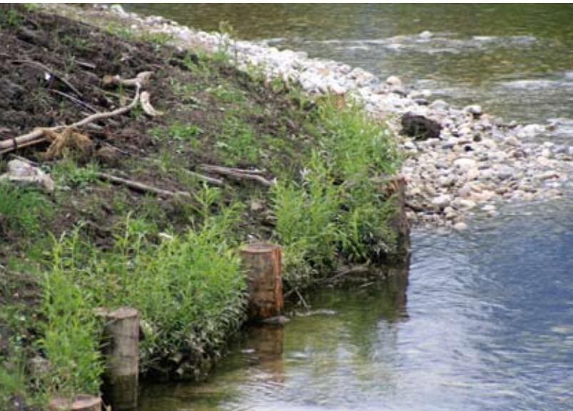
Das Weidengeflecht am Ufer wächst gut an und bietet so die gewünschte Stabilität.
