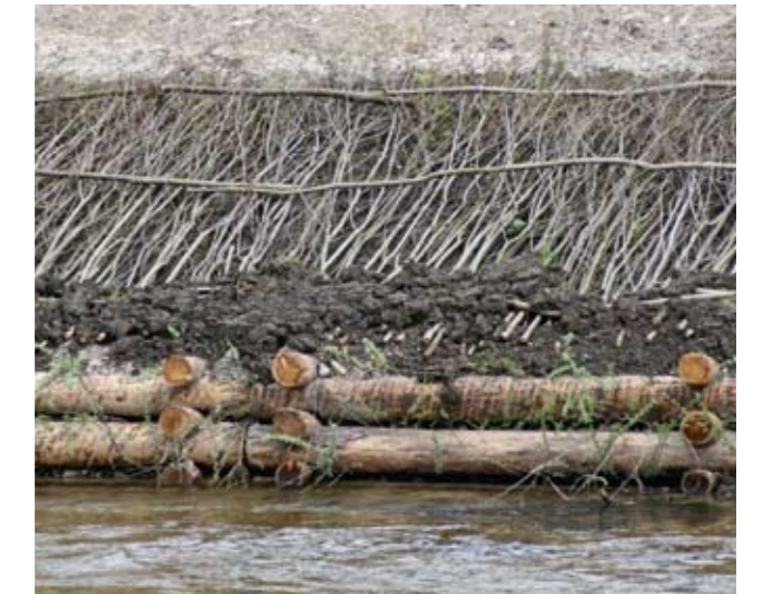
Zur naturnahen Ufersicherung werden Weidenflechtwerk...
