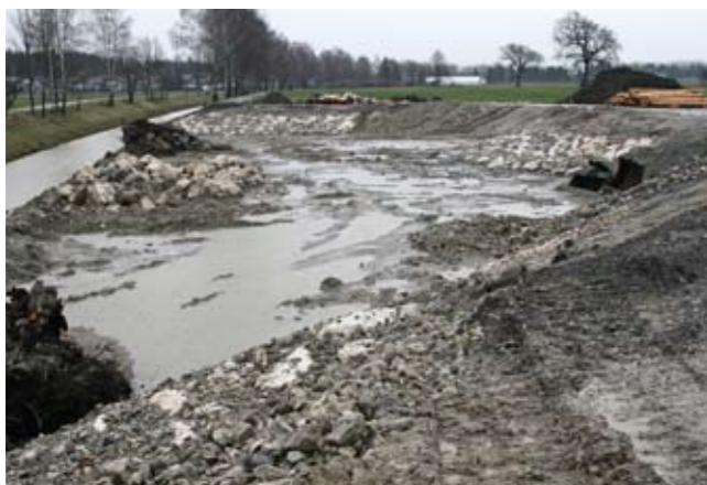
Der untere Aufweitungsberreich ist größtenteils ausgehoben, das Gewässer fließt vorerst noch in seinem alten Bett.
