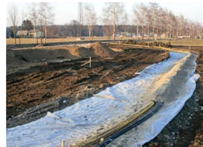
Sorfältig wird die Gasleitung am rechten Ufer neu verlegt und nach einer Druckprobe an das Netz angeschlossen.
